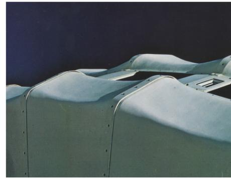
Une couche de polyuréthane expansé est compressé entre deux fines feuilles de fibre de verre renforcées de résine de polyester;
