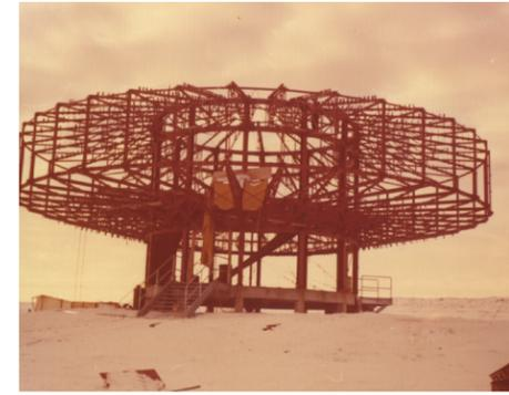
La conception circulaire permet aux bureaux et aux laboratoires d'ouvrir la zone centrale afin de minimiser l'espace au sol. Une structure légère en acier supporte les panneaux; dénote une faible implantation au sol; se déploie selon un système très strict en rayonnement régulier autour d'un axe; à l'image des panneaux de fibre de verre renforcés à la genèse de ce projet, la structure est répétitive.
